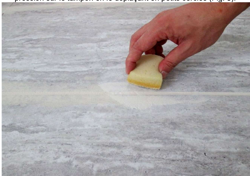
Fig. 3 - Exercer une légère pression sur le tampon en le déplaçant en petits cercles.
