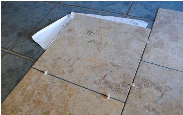
Fig. 1 - Placer des cales d'espacement pour obtenir toujours la même largeur de joints
