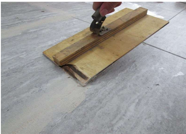
Fig. 2 - Faire pénétrer le coulis dans les joints
